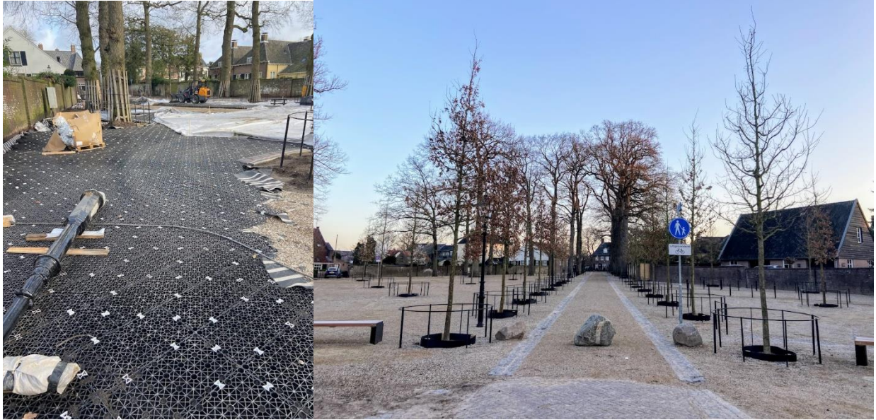
Het MT-plein werd klimaat-adaptief, kreeg infiltratiekratten voor water voor de bomen, nieuwe bomen en afwateringsgoten.
