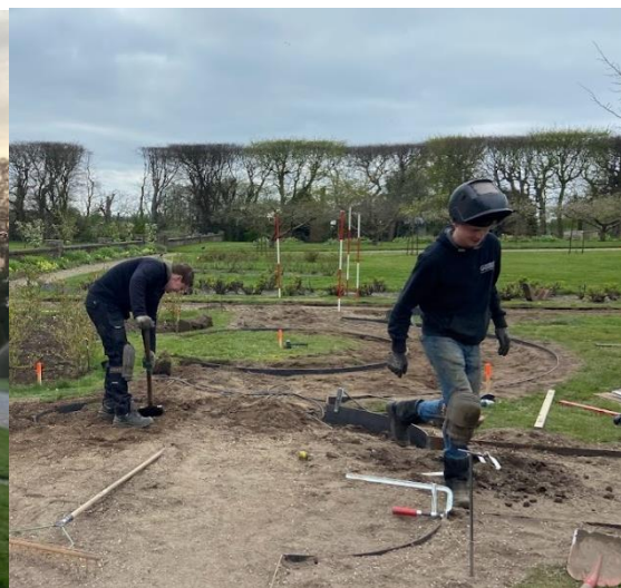
Alle gazons krijgen kantopsluiting van cortenstaal
